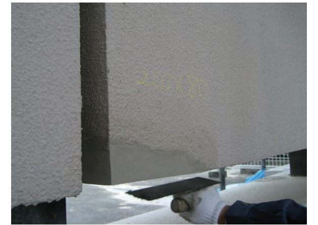
充填材の充填・仕上げ
